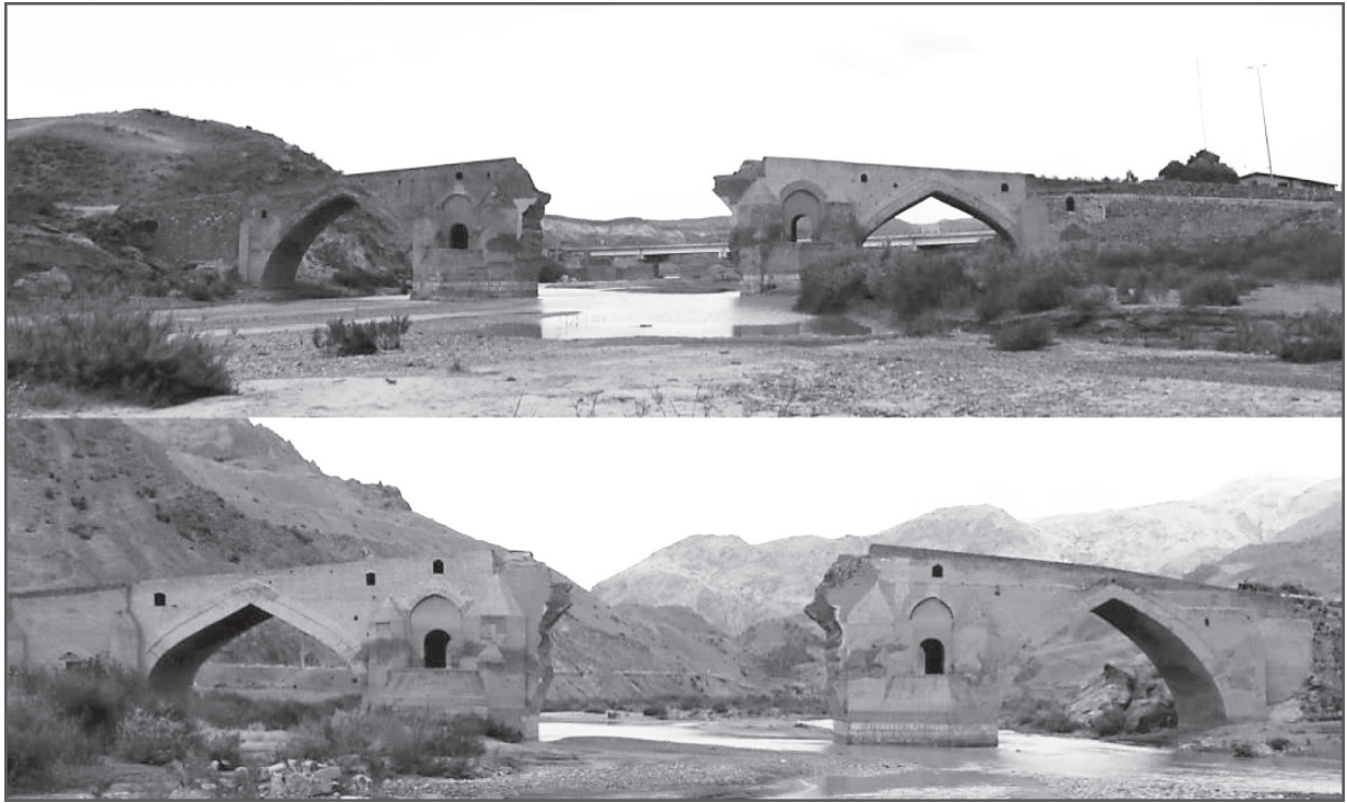
تصویر ۴. نمای شمالی [پایین] و نمای جنوبی [بالا] از پل دختر میانه که قوس‌ها و آب‌برها را نشان می‌دهد (عکس از: نویسندگان).
